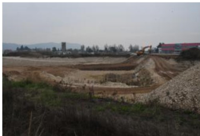
Il cantiere della Pedemontana a Brogliano. ARCHIVIO
