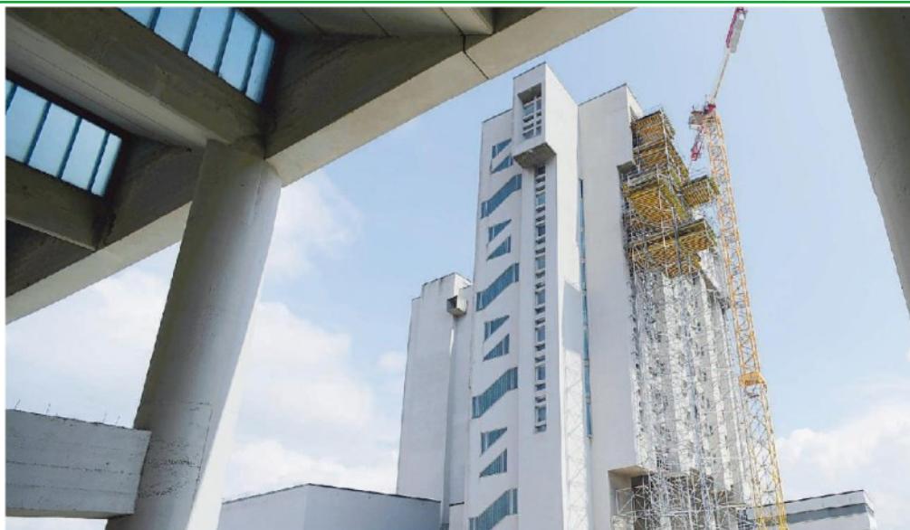
La grande gru affiancata ad una delle due Torri dell'ospedale di Cattinara, diventata ormai il simbolo della paralisi del maxi cantiere
