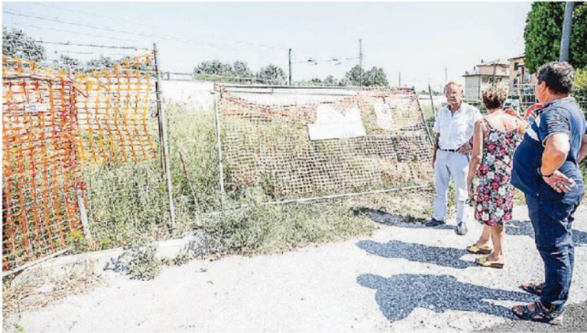
I residenti di via VIII Alpini mostrano il cantiere in abbandono
