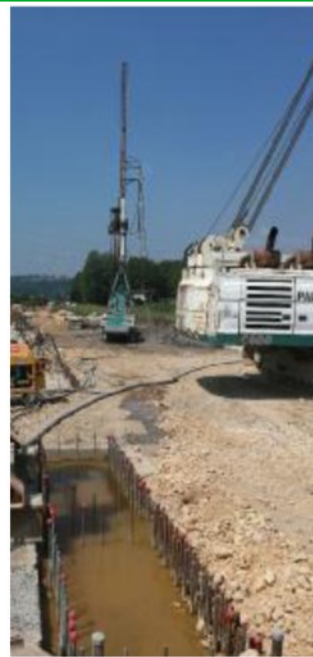
Un'altra fase del cantiere
