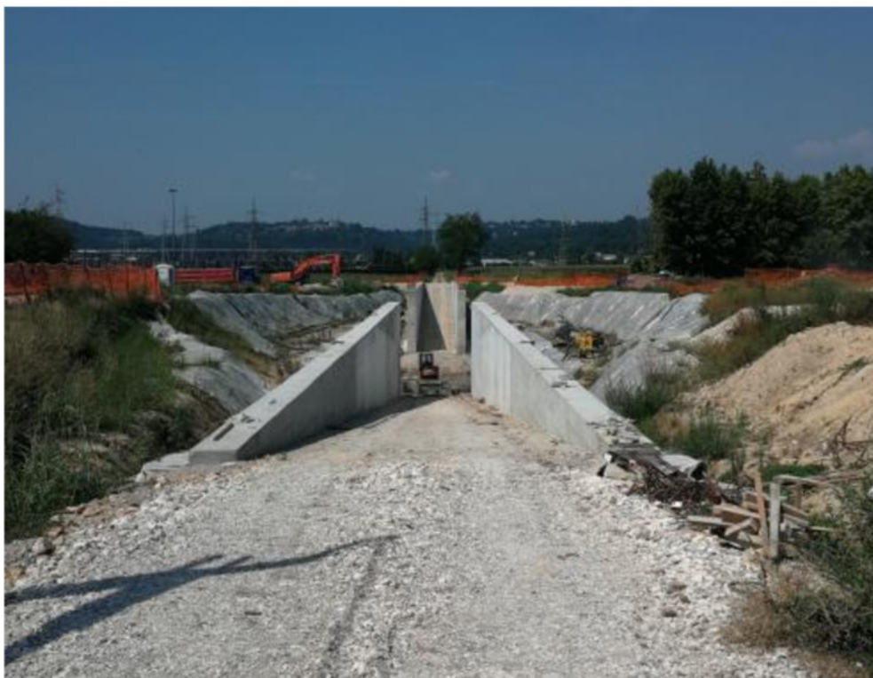
Il sottopasso poderale è in fase avanzata: sono state quasi completate le rampe
