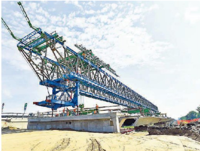
Lavori in A4 per la realizzazione della terza corsia
