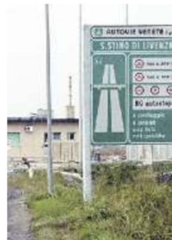
CASELLO AUTOSTRADALE Il casello di San Stino
