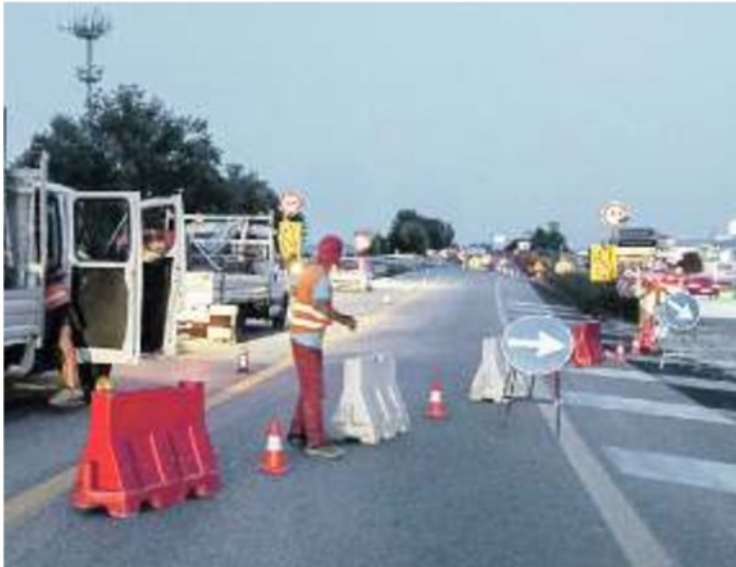
LA CHIUSURA La tangenziale chiusa dalle 21 per i lavori sul ponte
