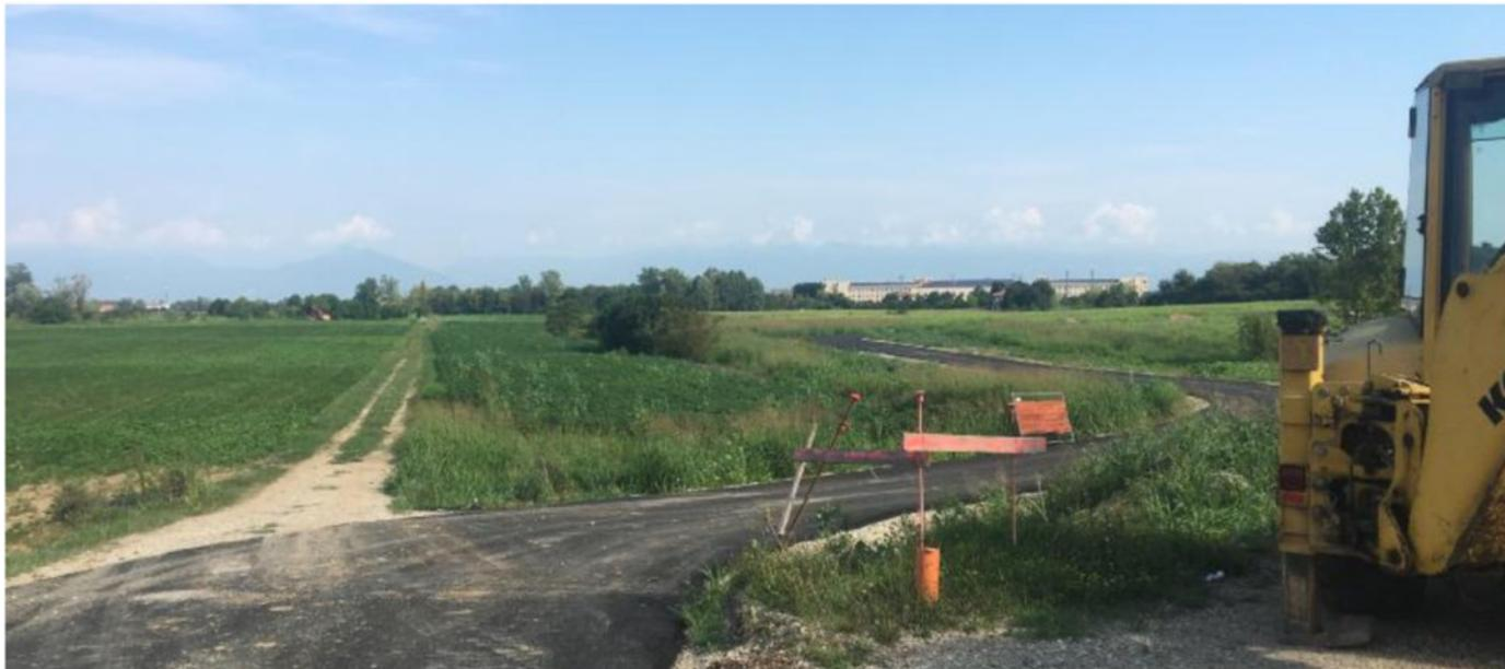
Il cantiere avviato per la realizzazione del bacino di laminazione di viale Diaz: è stata realizzata una strada per agevolare gli spostamenti dei macchinari
