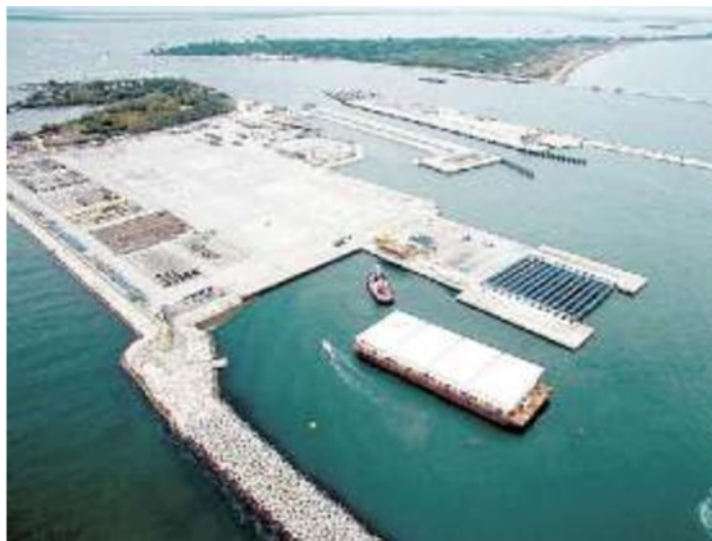
CANTIERI I lavori per il Mose alle bocche di porto
