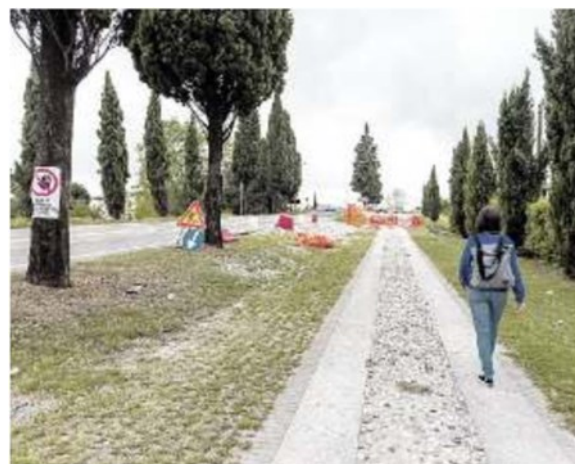
IN SOSPELO Viale delle Rimembranze, i lavori sono fermi
