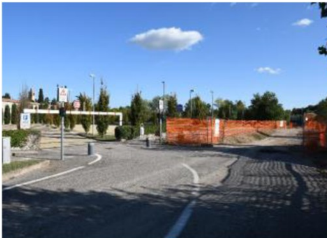
L'area recintata nelle vicinanze del cimitero
