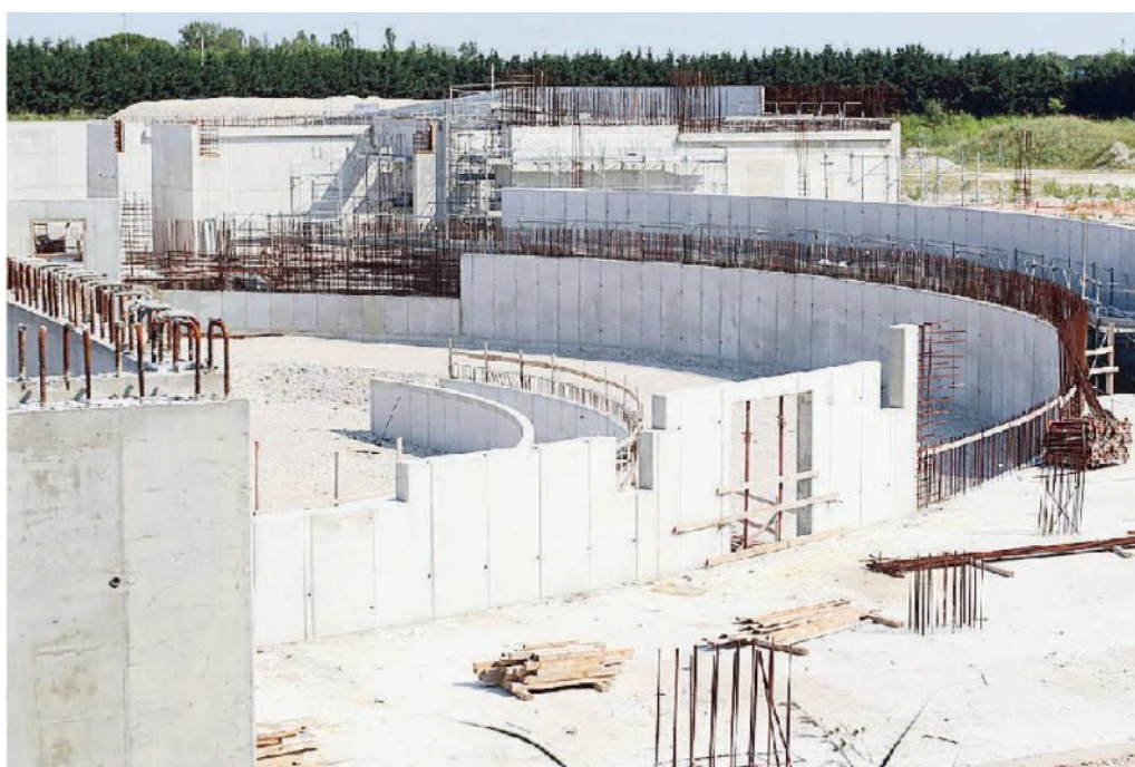
Il cantiere del velodromo a Lovadina: tutto è stato bloccato (foto Film)
