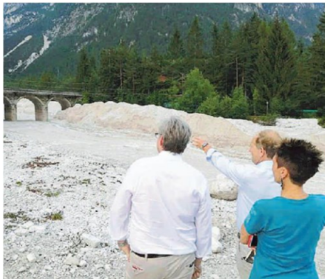
Uno dei sopralluoghi post Vaia fatti ad Auronzo
