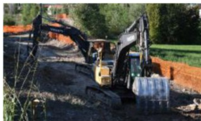
Peschiera: ruspe in azione per realizzare la strada necessaria al centro logistico Tav, il «quartiere» che ospiterà gli operai che lavoreranno all'Alta velocità
