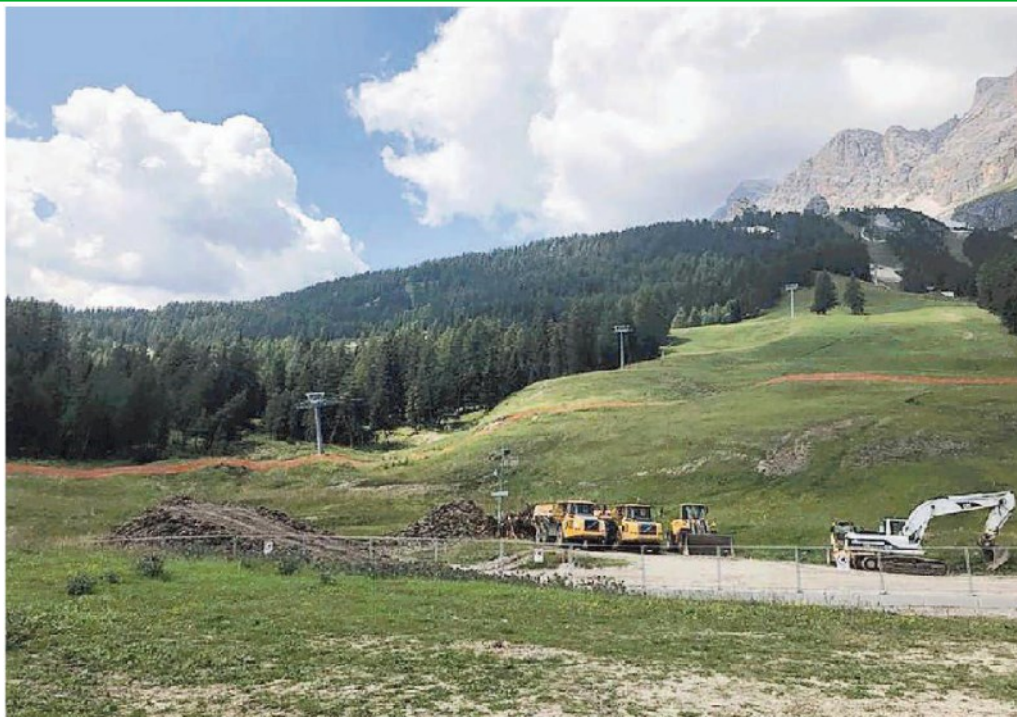
I lavori nell'area di Rumerlo
