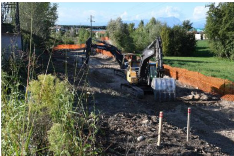
Primi lavori per conto di Cepav due: qui si realizza la pista di servizio al cantiere FOTO PECORA
