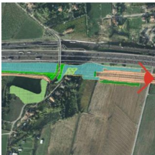
Il tracciato che costeggia l'autostrada per un tratto in galleria
