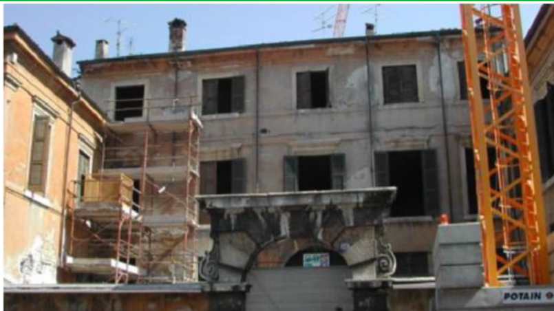
La ristrutturazione di un vecchio palazzo
