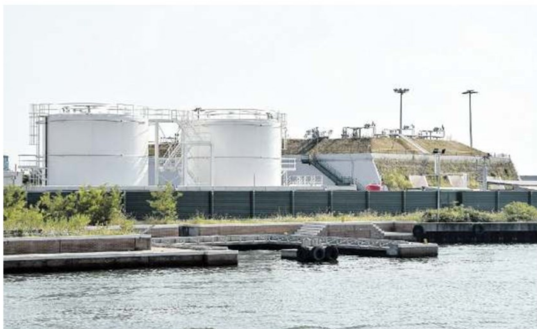
VAL DA RIO Il deposito di Gpl in fase di realizzazione nel porto di Chioggia
