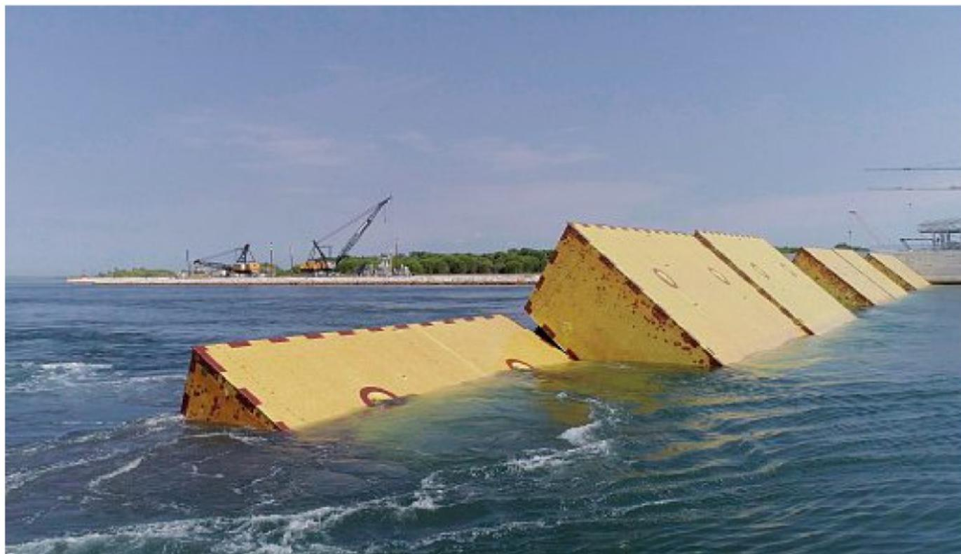
Un muro nascosto sott'acqua Il test di sollevamento delle paratoie del Mose alla bocca di porto di Chioggia
