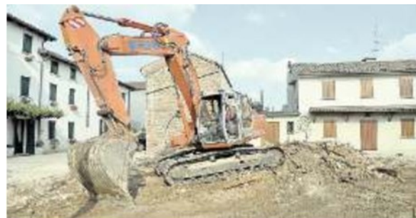
CANTIERE Una ruspa mentre abbatte un edificio
