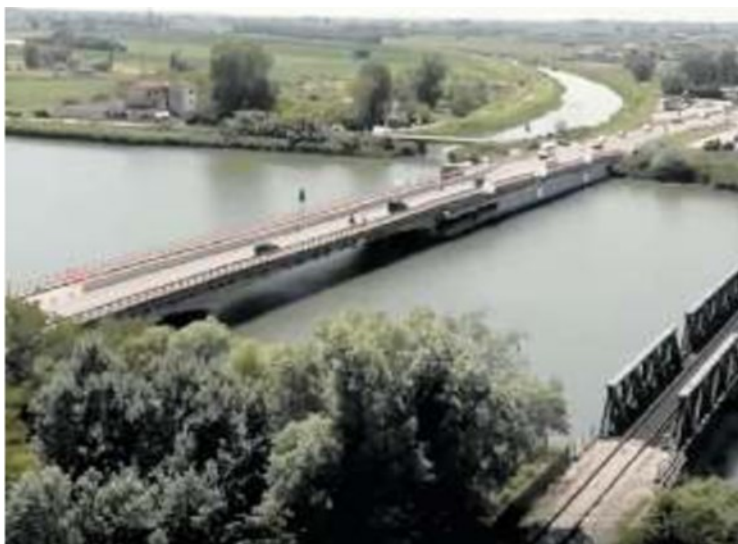
PONTE SUL BRENTA Al via i lavori. In alto, il sindaco Alessandro Ferro
