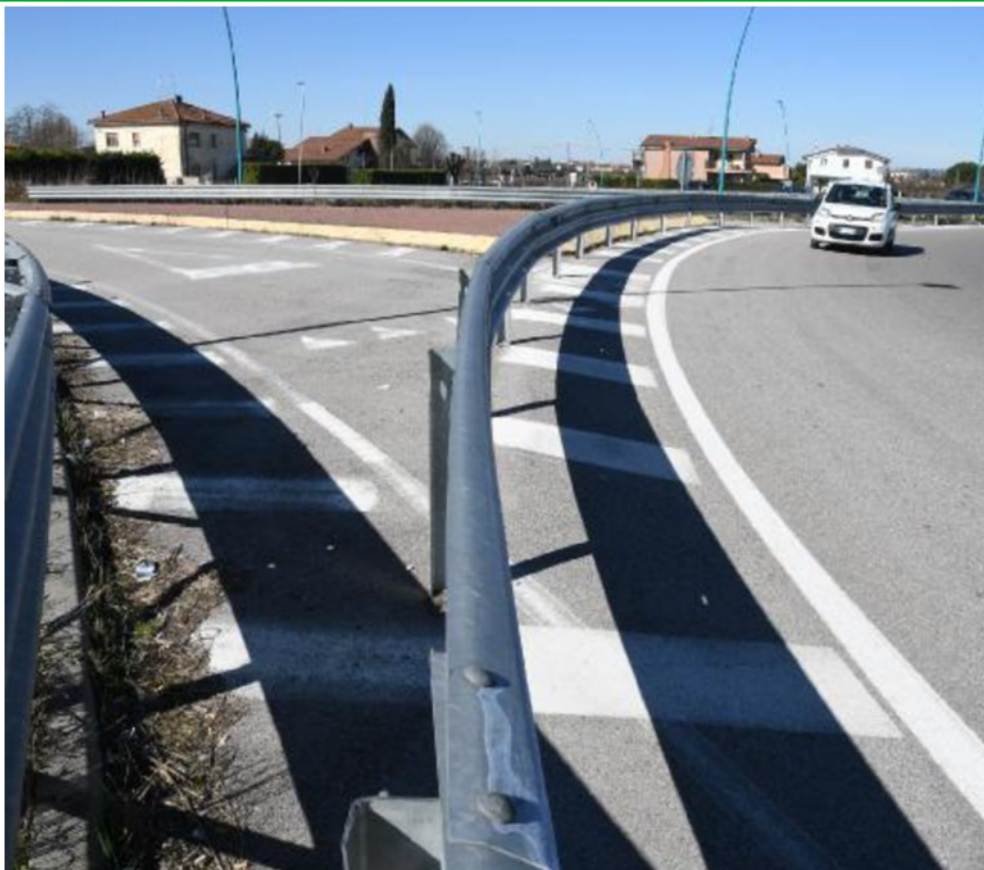
L'imbocco del tratto incompiuto della Grezzanella nel territorio di Villafranca
