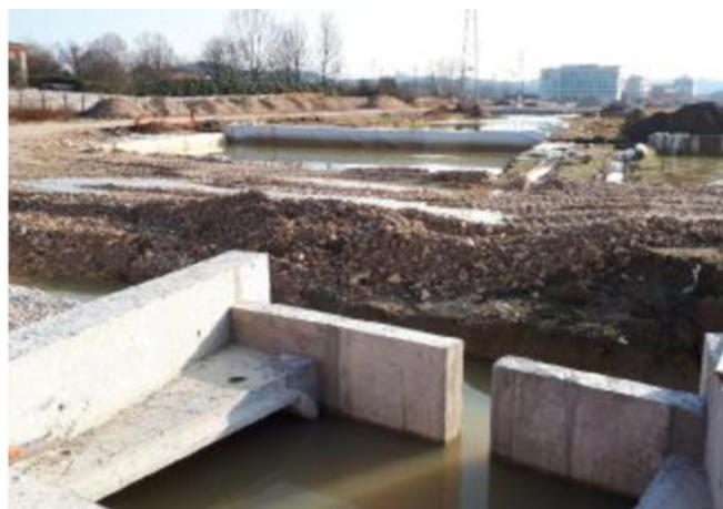
I lavori in corso all'interno del cantiere della bretella dell'Albera
