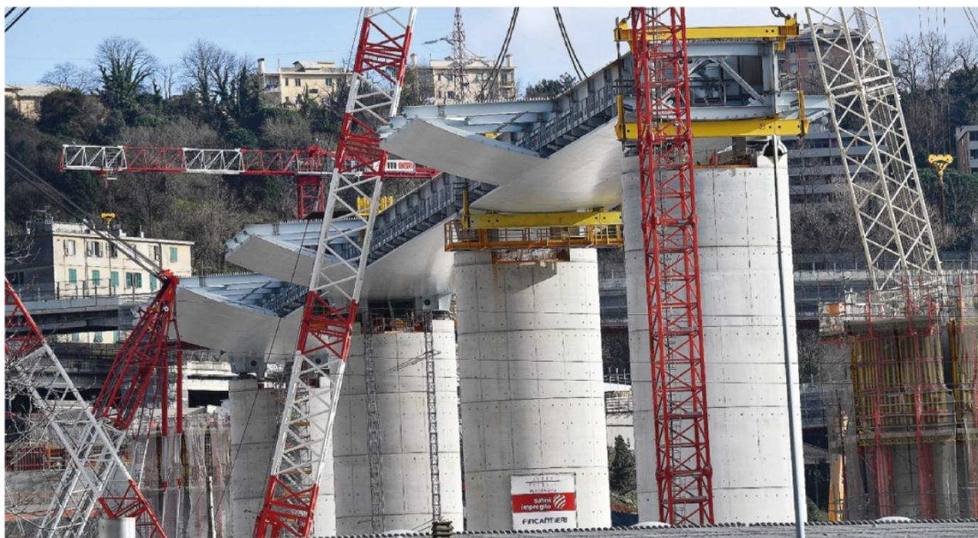
**Opera simbolo.** Anche l'ultimo gigante di calcestruzzo è stato terminato. Nel cantiere del nuovo ponte di Genova si sono conclusi i lavori sulla pila 12, uno dei 18 piloni che sorreggeranno l'impalcato di oltre mille metri. L'opera rappresenta un'importante tappa raggiunta nel percorso di costruzione del viadotto
