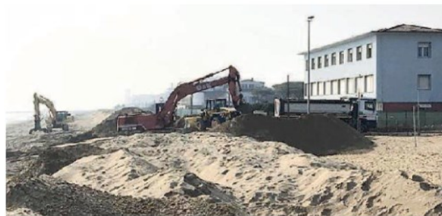
I lavori di ripascimento in corso a Jesolo Pineta
