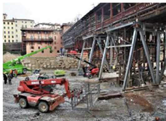
Mezzi e uomini della Inco al lavoro
