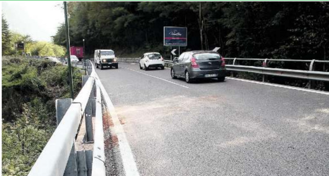
ALEMAGNA L'intervento riguarderà il tratto di strada dallo svincolo di Castellavazzo all'imbocco della galleria di Termine
