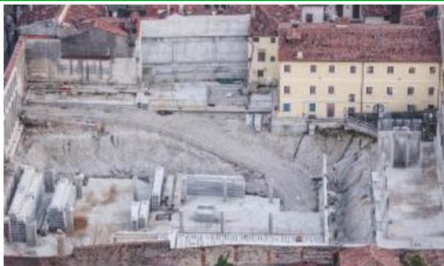
Il cantiere del polo Santa Chiara in una veduta aerea CECCON
