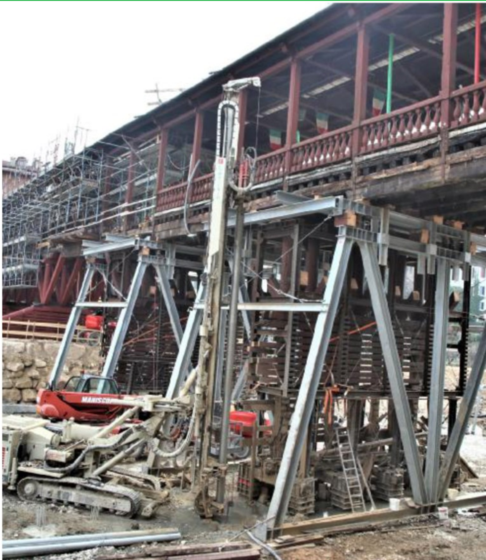
Il Ponte sostenuto da un "castello" di travi in acciaio FOTOSERVIZIO CECCON
