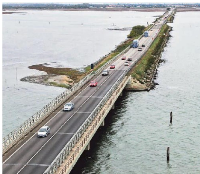
Una veduta del ponte translagunare verso Chioggia
