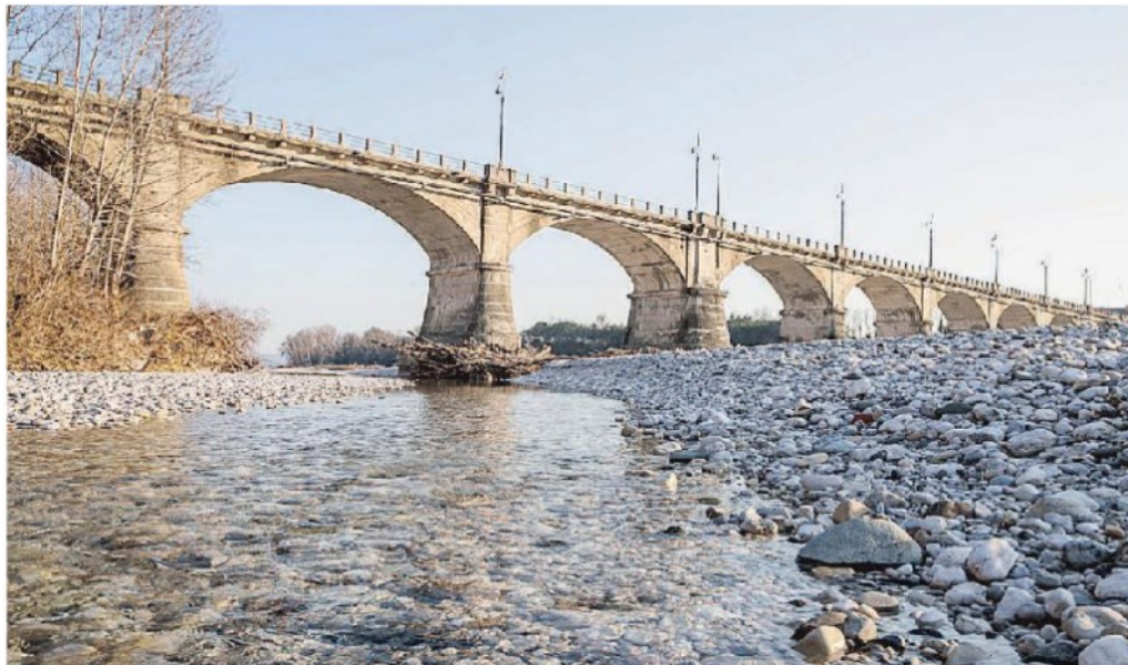
Lo storico viadotto sul Piave di Vidor
