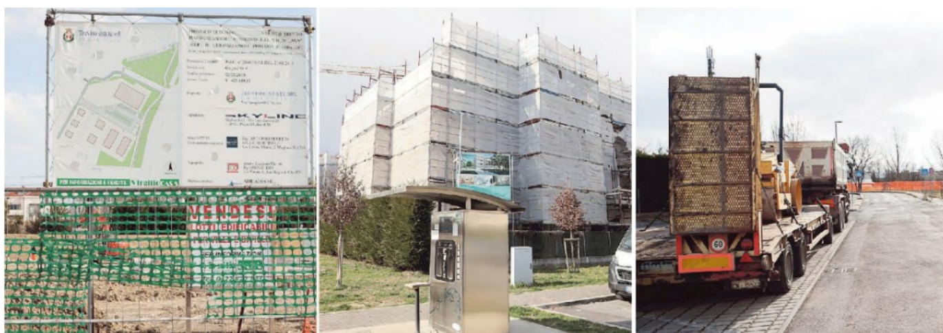
Da sinistra il cartello del cantiere dei lavori per la realizzazione della lottizzazione Col di Lana. Il cantiere per l'edificazione di uno dei tre condomini del Ghirada Village Treviso e l'altra area edificabile in via Sarpi
