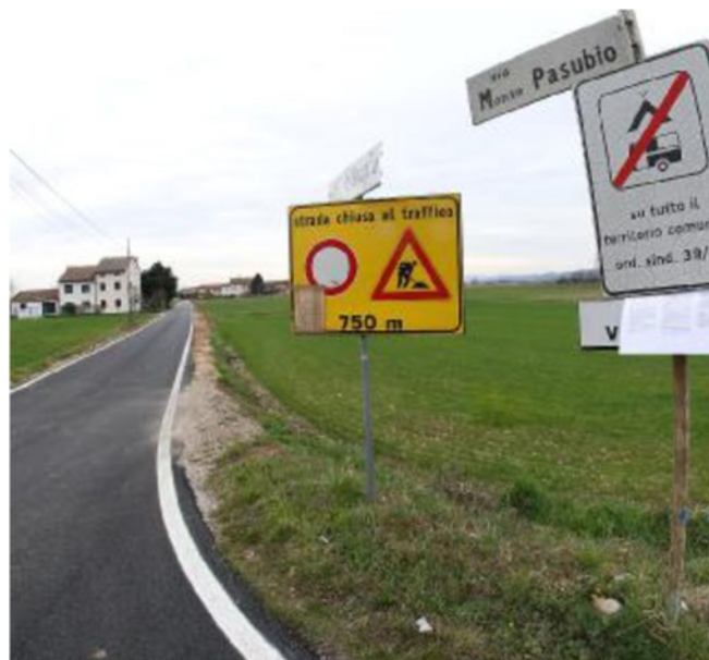
La strada comunale via Monte Pasubio e via Braglio. FOTO CISCATO
