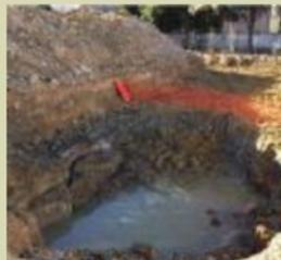
A una profondità di tre metri è emersa una vecchia cisterna circolare in calcestruzzo armato con diametro di 6 metri
