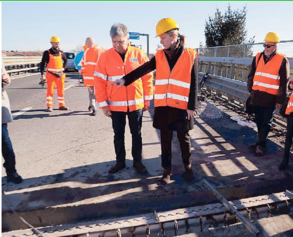
L'assessore regionale De Berti in un cantiere di Veneto Strade lungo la tangenziale di Treviso
