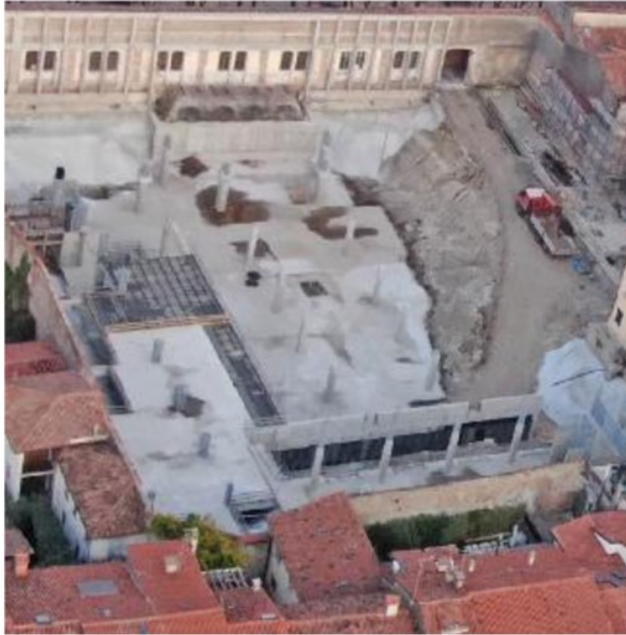
Il cantiere del Polo Santa Chiara FOTO CECCON
