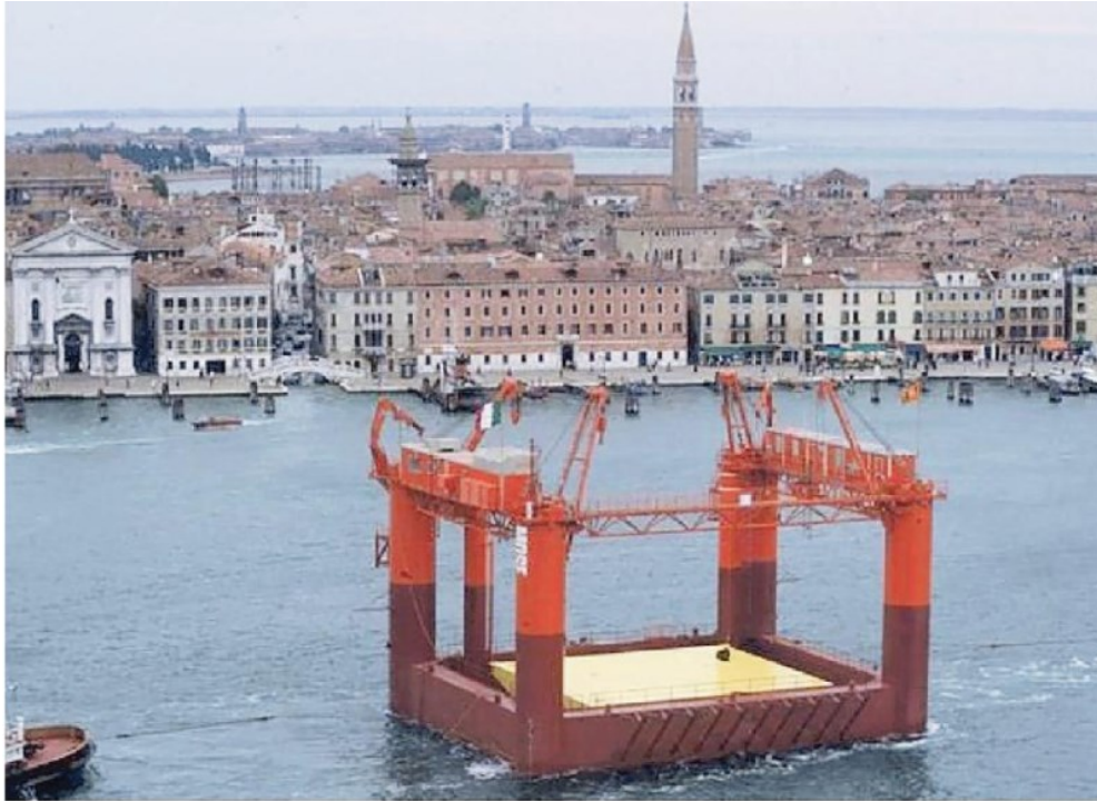
La mega inaugurazione per la posa della prima pietra nel 2003
