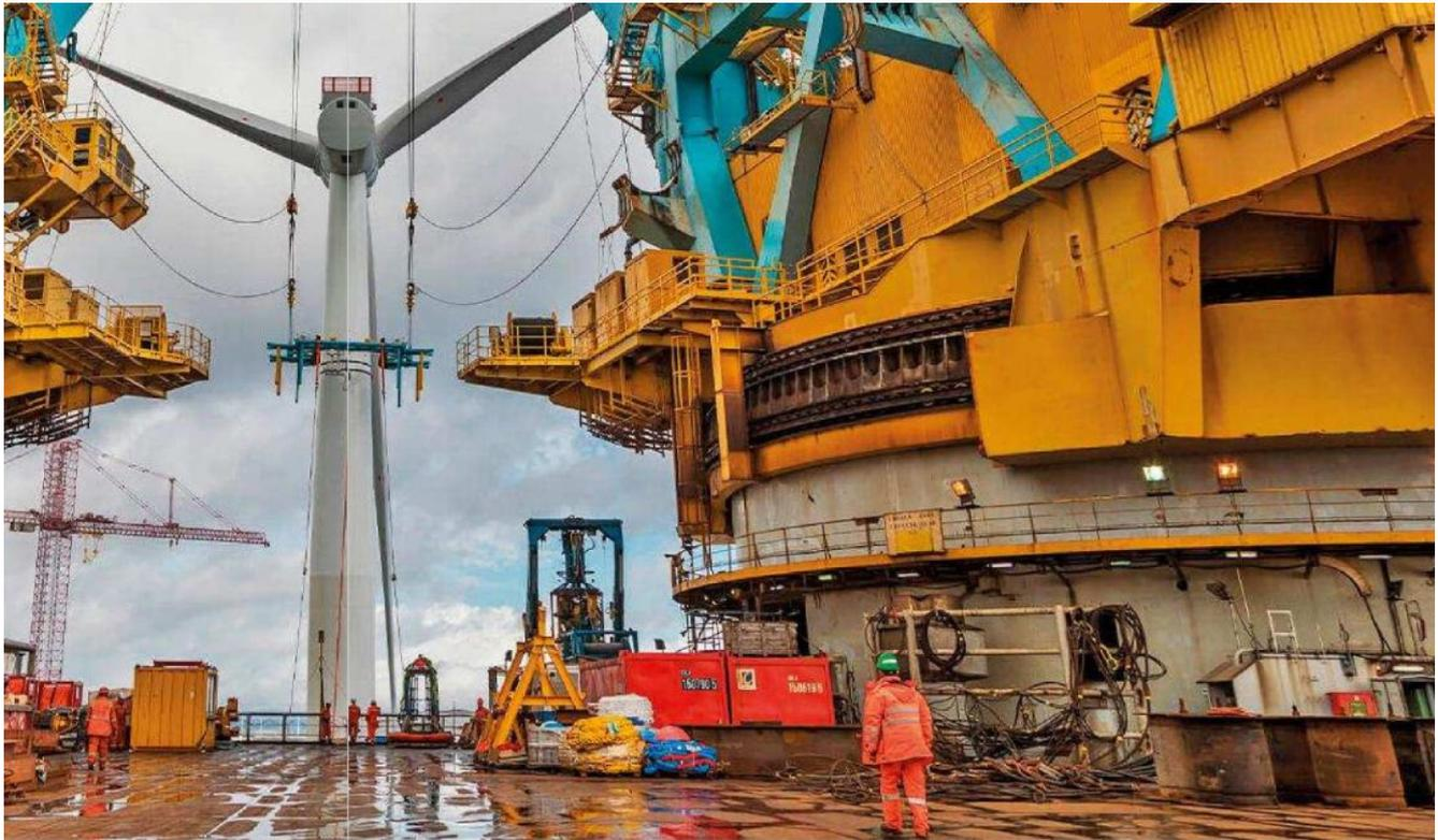
La piattaforma Saipem che sta installando pale eoliche "off shore" al largo della costa scozzese nel progetto sperimentale "Hywind"
