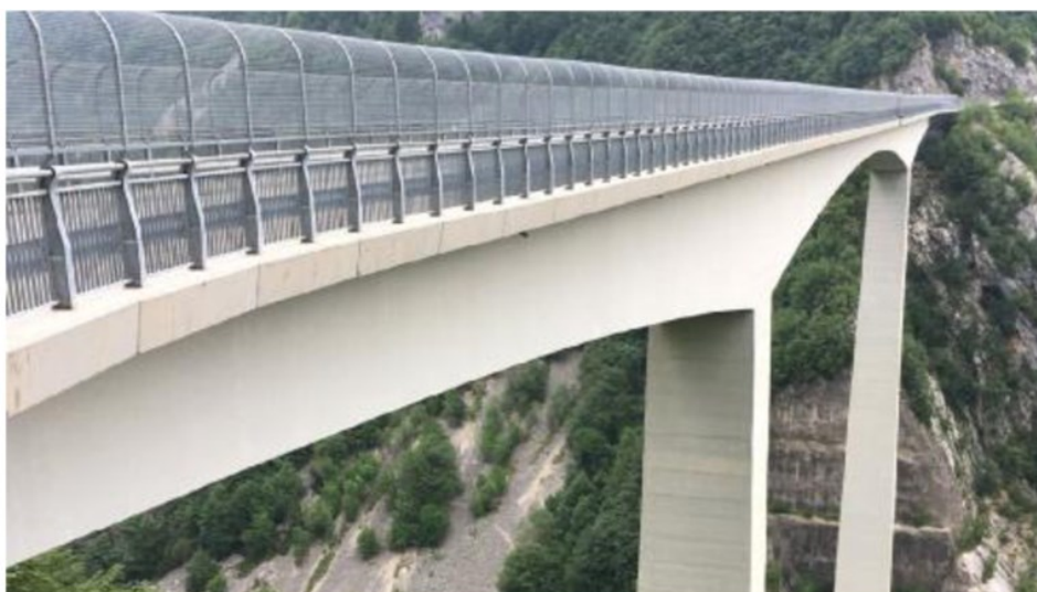
Il viadotto Valgadena tra Foza ed Enego è uno dei più alti d'Europa
