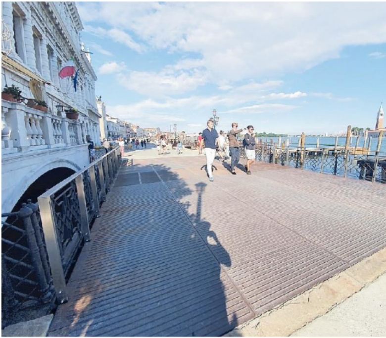
I primi attraversamenti sul nuovo ponte della Zecca
