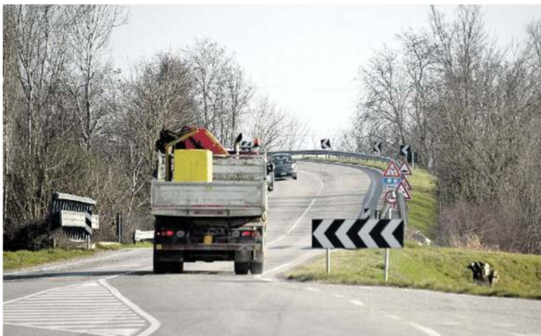
VIABILITÀ Il ponte sulla Provinciale 70 ha urgenza di lavori di manutenzione: l'intervento richiederà lo stop al traffico
