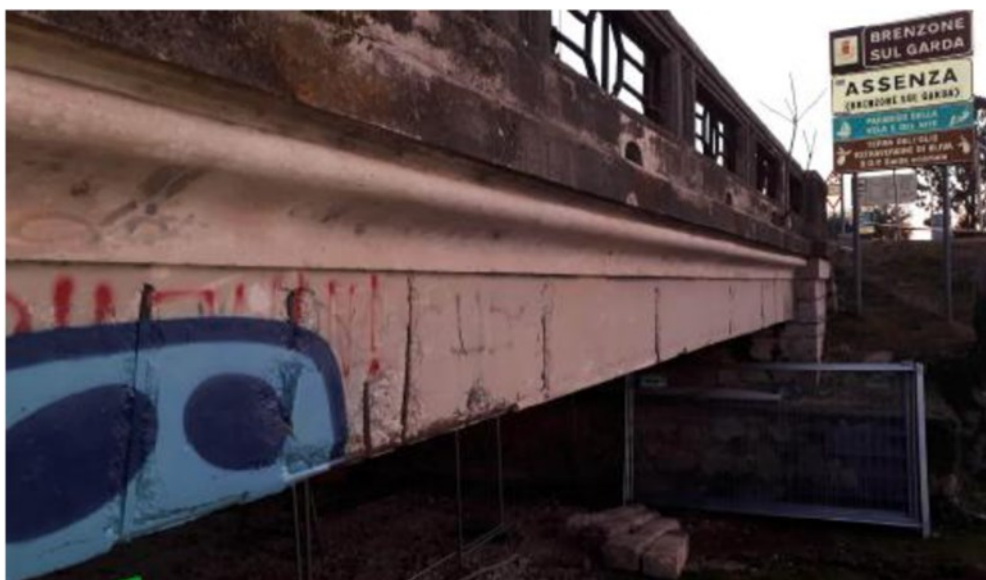
Il ponte sulla Gardesana all'altezza del confine di Malcesine con Brenzone
