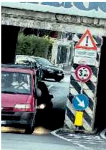
VERRA' ristrutturato anche il sottopasso di via Venier
