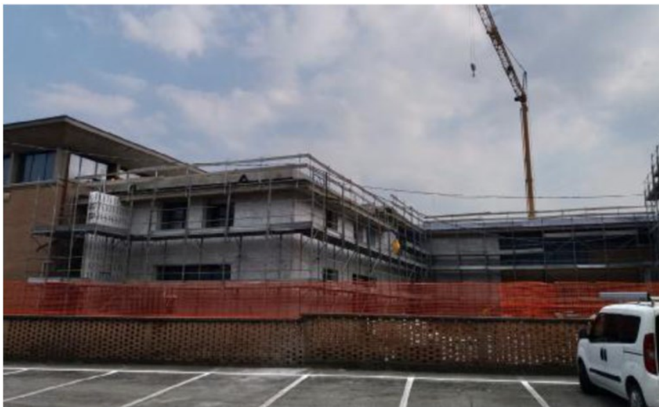
I lavori in corso alla scuola media del capoluogo FOTO ZARPELLON
