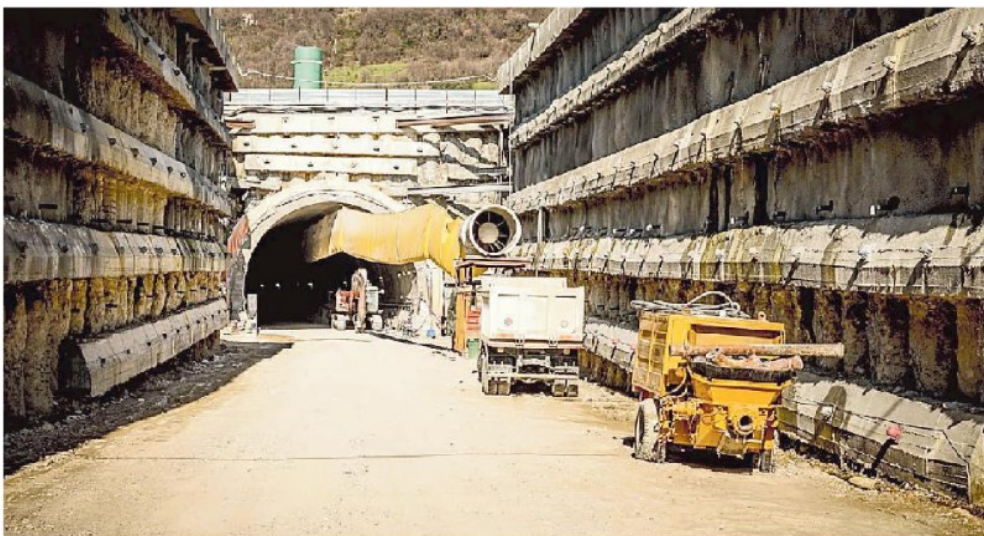
Il cantiere del traforo di Sant'Augusta. Oggi possibile sopralluogo del presidente di Anas
