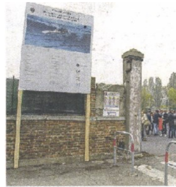
PISCINA I lavori nel cantiere
