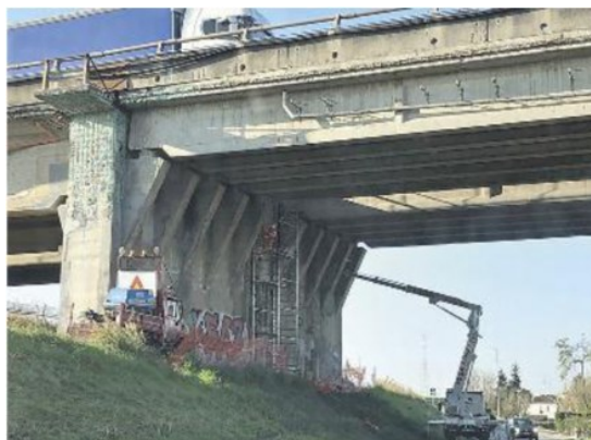
La prima fase di lavori di ristrutturazione proseguirà tra i 70/90 giorni e sarà a cura della 'Padana Interventi srl'
