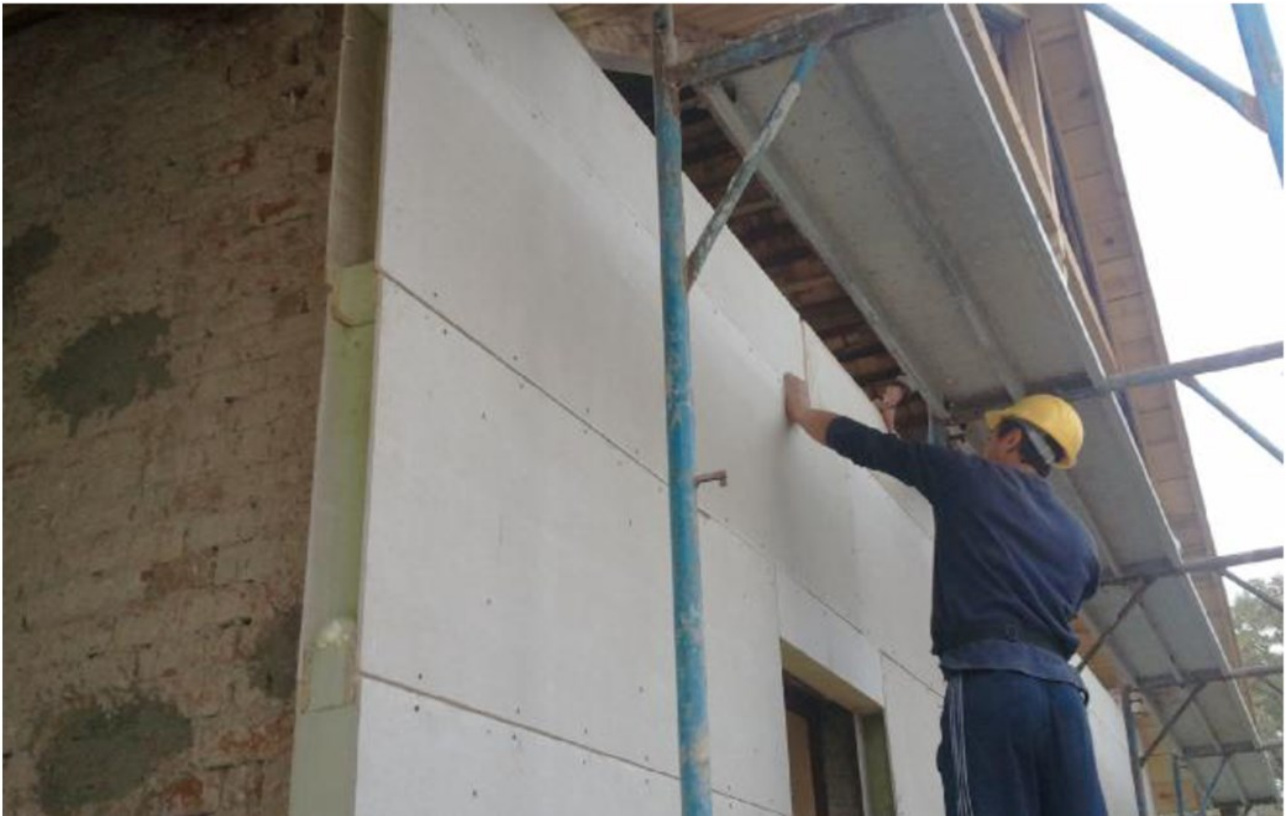
Un intervento di isolamento termico: il superbonus con agevolazioni al 110 per cento è un'opportunità da valutare subito. ARCHIVIO
