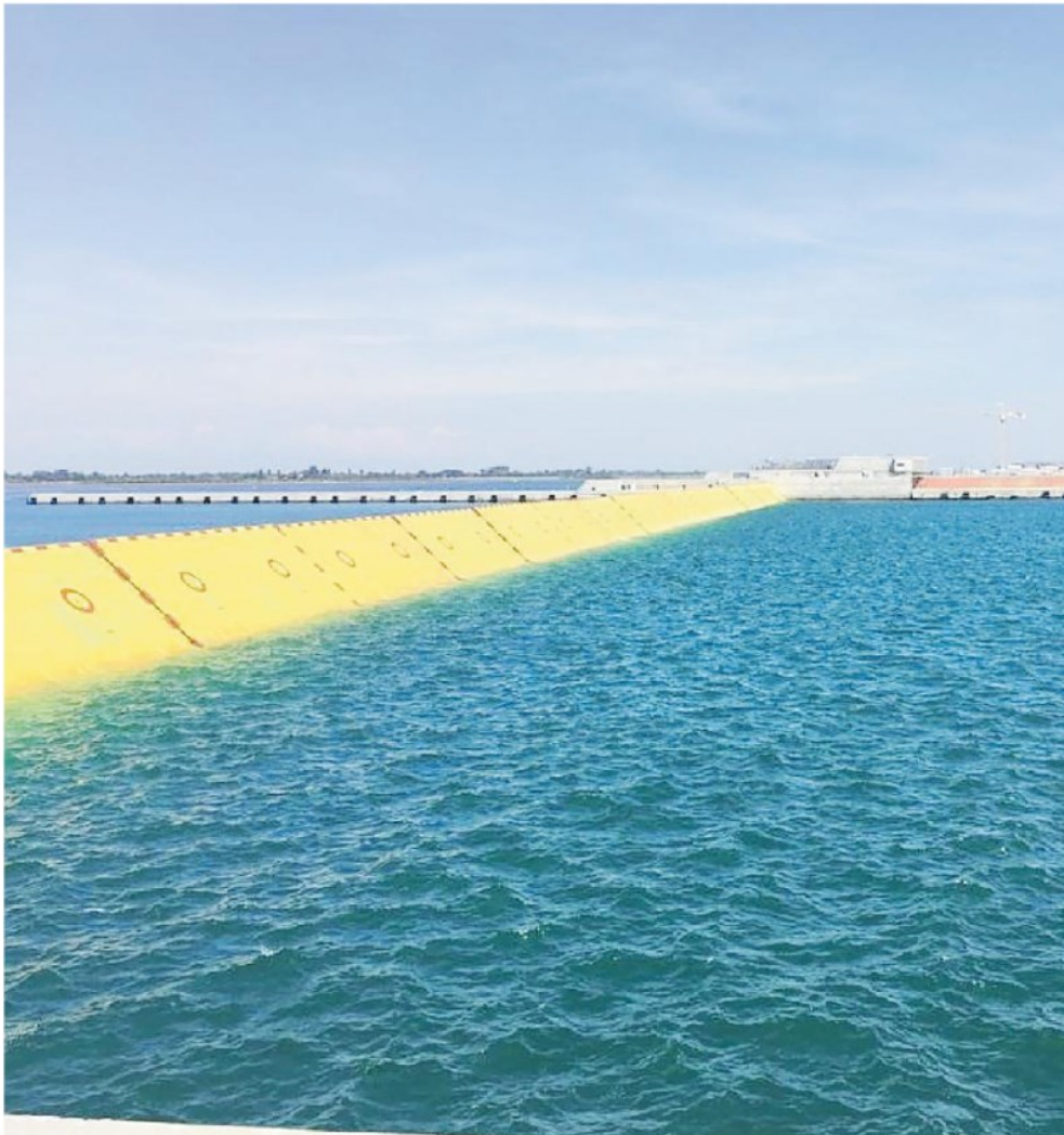
Le paratoie alzate al Lido: la grande opera ha dei problemi da risolvere, in vista della messa in funzione
