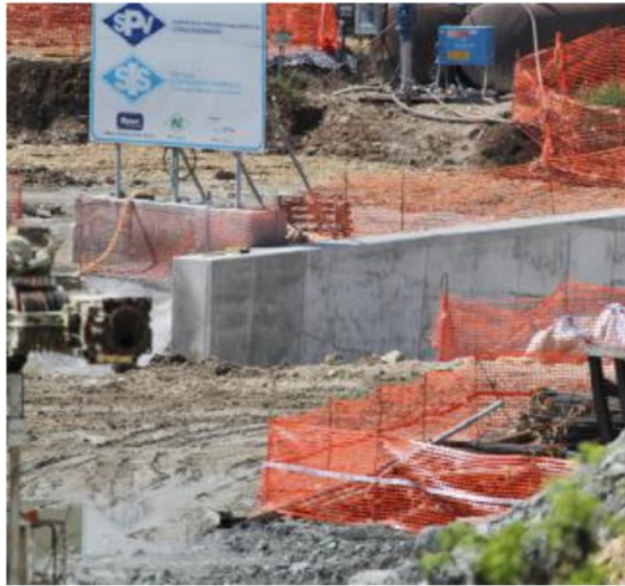
Il cantiere della galleria "Malo" all'epoca dell'infortunio mortale
