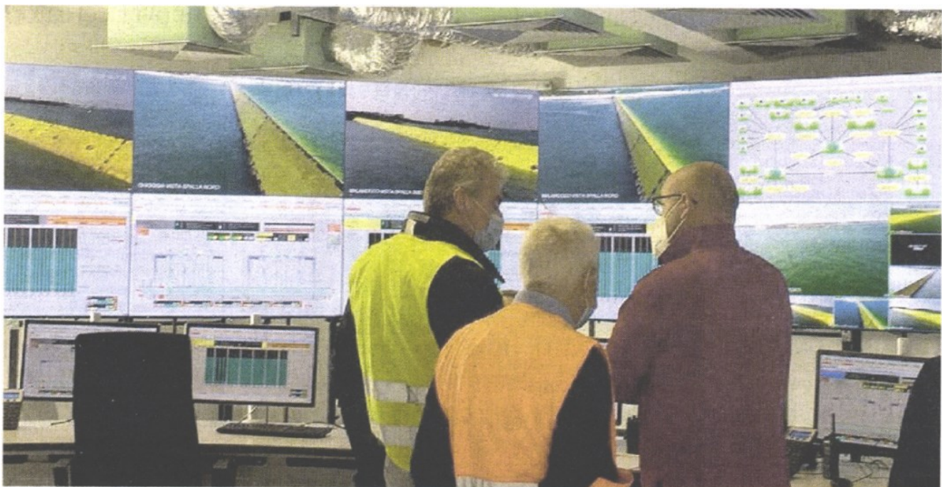
LA SALA CONTROLLO Tecnici e operatori in control room durante una delle prove del Mose
