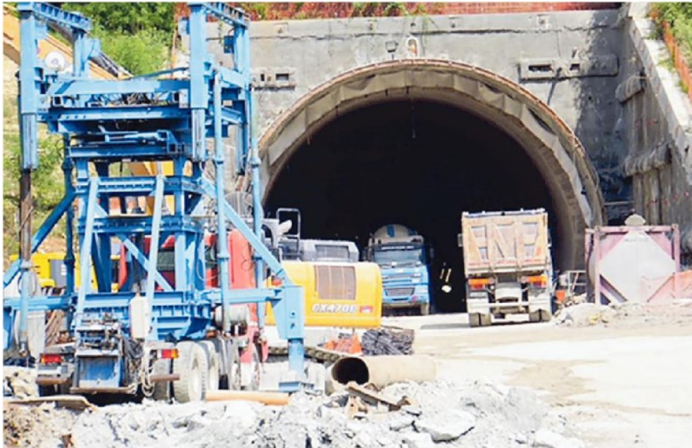
Il tunnel nella galleria di Malo, nel Vicentino: la magistratura ha dissequestrato i cantieri
