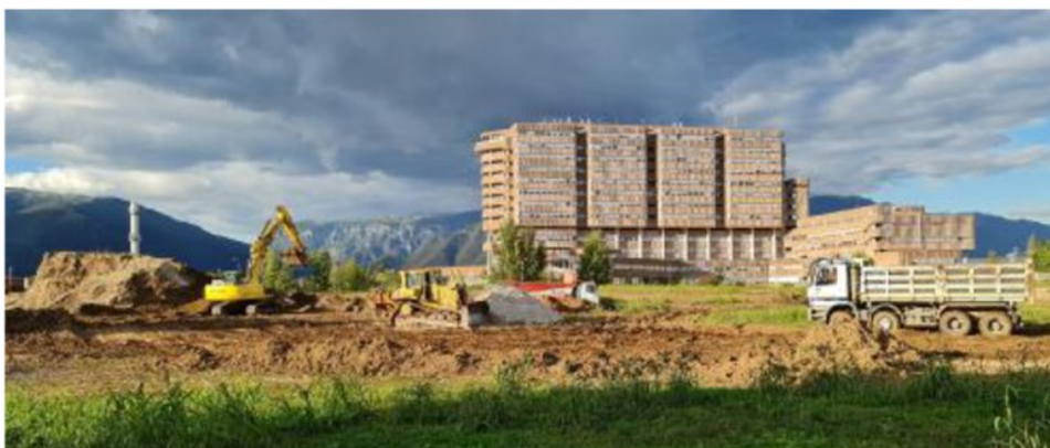
I lavori in corso nell'area verde a sud dell'ospedale San Bassiano FOTO CECCON
