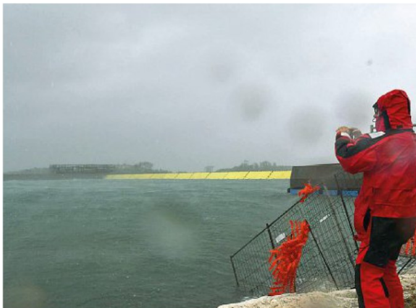
Paratoie Il Mose alzato a Malamocco nella mattinata di ieri per evitare l'alta marea in laguna causata dalla bora (Foto Vision/Sabadin)
