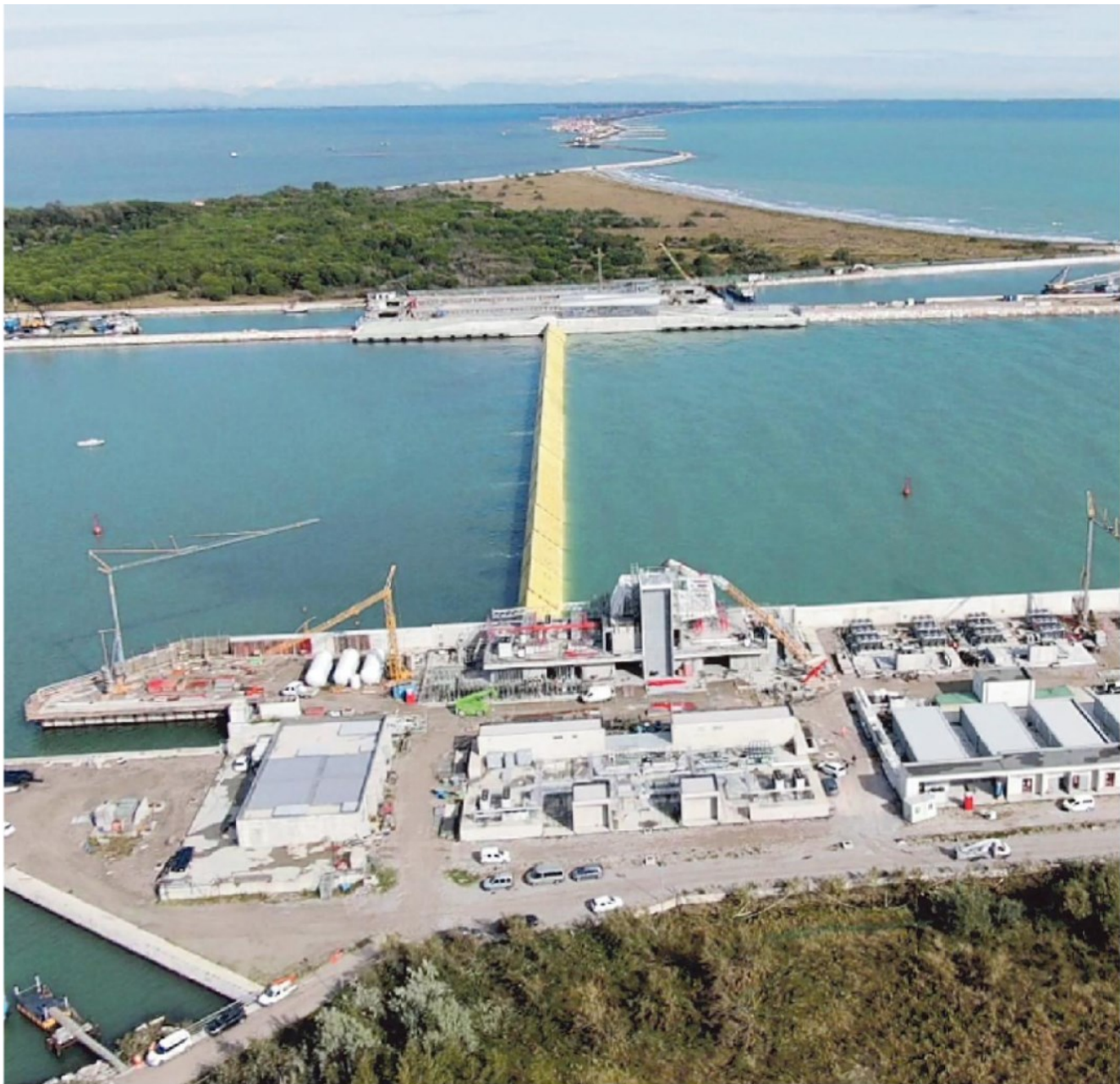
Il cantiere del Mose a Sottomarina e sullo sfondo le paratoie alzate dopo le previsioni di marea a 130 centimetri
