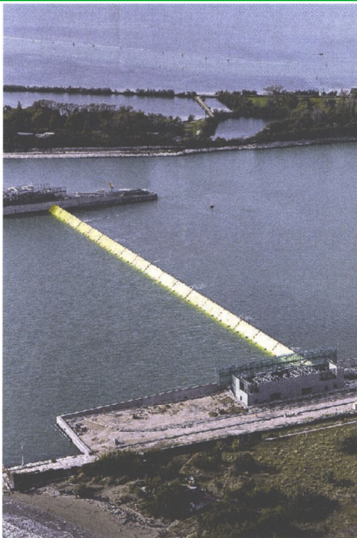
LIDO La bocca di porto di Malamocco, la più larga, profonda e quella attualmente più importante perché attraverso il canale dei Petroli le navi raggiungono il porto commerciale. E dunque quella la cui chiusura crea i disagi più sostanziosi. Sullo sfondo l'isola di Pellestrina.
