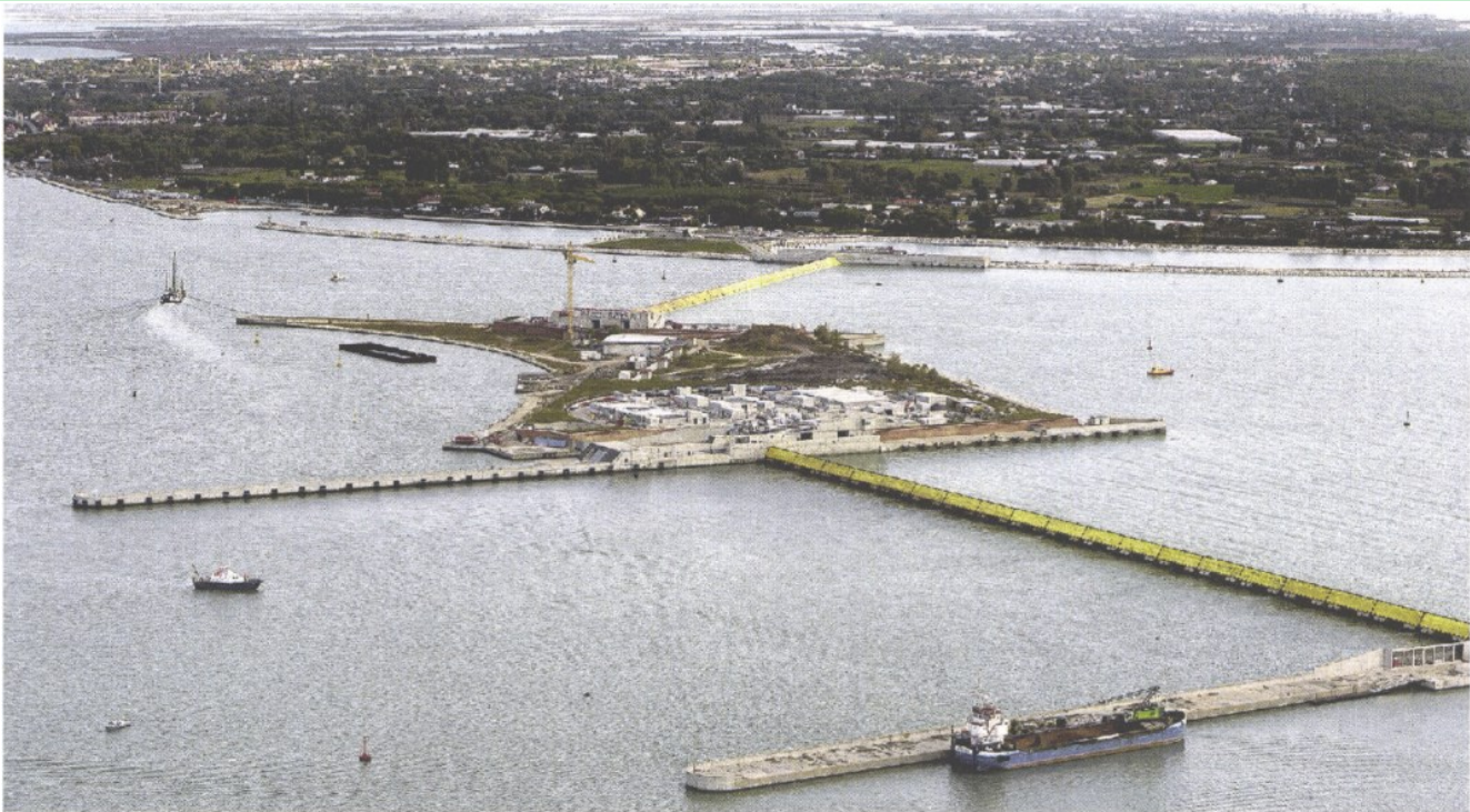
LIDO Ecco la bocca di porto di Treporti, vista da sopra il Lido: sullo sfondo Punta Sabbioni e Cavallino, al centro l'isola artificiale realizzata dal Consorzio Venezia Nuova come punto d'appoggio tra due schiere di paratoie
