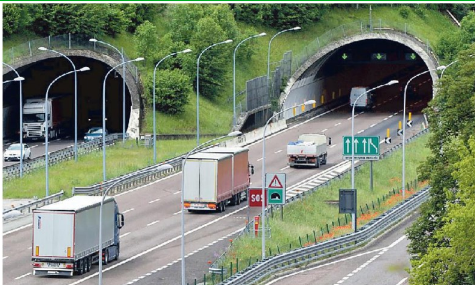
Le gallerie sulla A4 Brescia-Padova all'altezza di Vicenza. La concessione scade nel 2026
