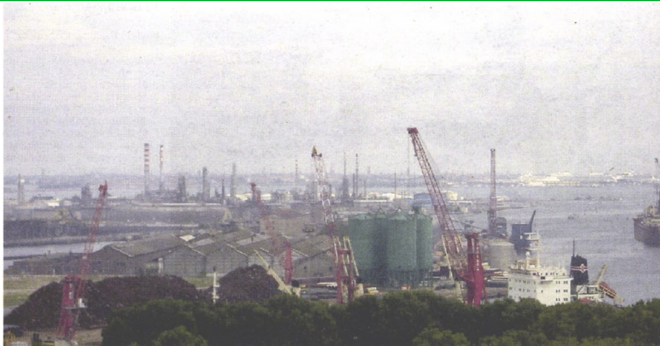
PORTO MARGHERA L'area del Consorzio Multimediale Darsena vista dalla Heritage Tower, ex torre di raffreddamento dell'Agrimont
