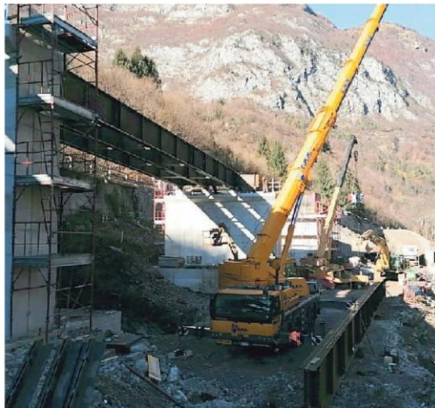
Una delle gru impegnate nel varo delle campate del ponte
