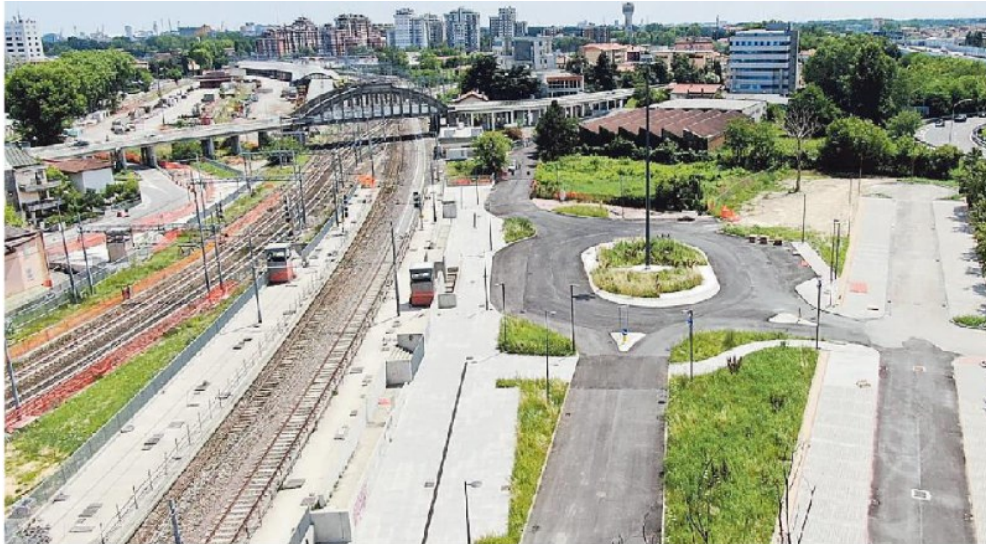
Il grande cantiere alla Gazzera per la stazione Sfmr, l'altra sta nascendo in via Olimpia
