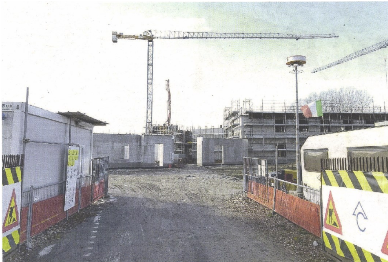
CANTIERE L'avanzamento dei lavori della nuova casa di riposo che si svilupperà su una superficie di 7.500 metri quadrati
