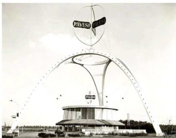
Villoresi story. Il presente e il passato dell'Autogrill Villoresi (autostrada dei Laghi). Nella prima foto in alto: il cantiere per la ricostruzione dell'Autogrill; nelle due foto al centro: gli interni rinnovati come si presentano oggi; sotto: l'edificio originale nel 1958, anno della costruzione
