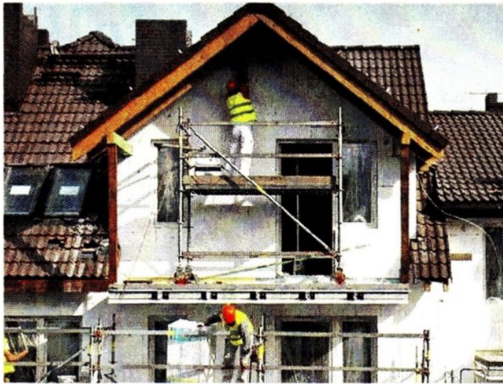
Un intervento di ristrutturazione edilizia
