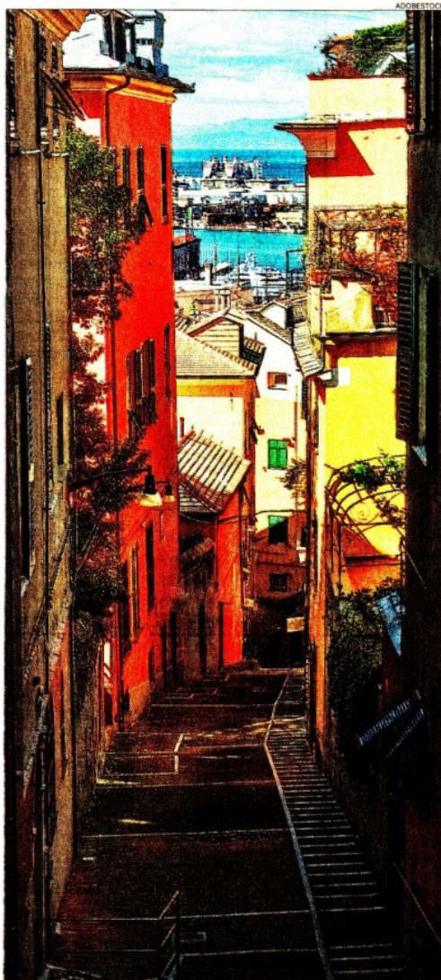
Riscatto per Genova. Il piano "Caruggi" punta al recupero del centro storico
