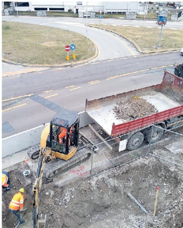
Un cantiere stradale
