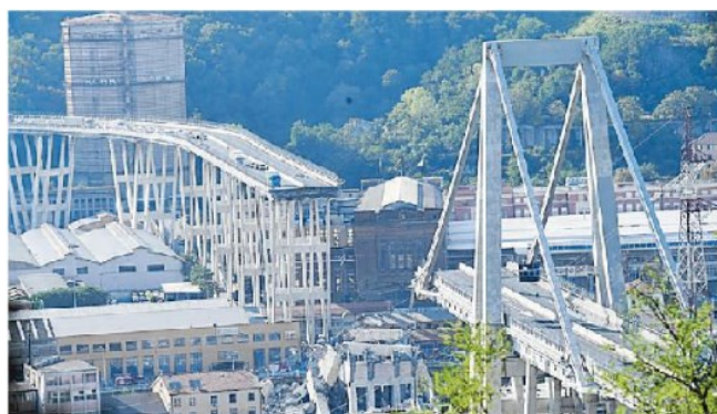
Il ponte Morandi a Genova crollato il 14 agosto del 2018
