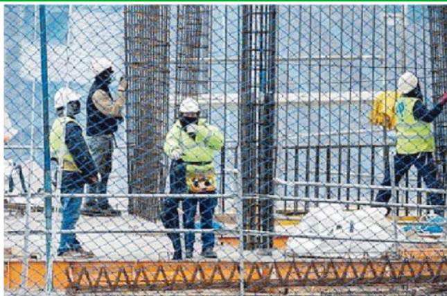
Operai al lavoro in un cantiere edile
