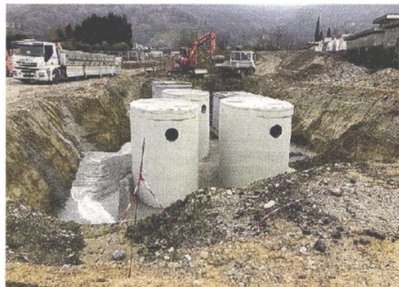
CRITICITÀ RISOLTA I pozzi di raccolta sotto la futura rotatoria
