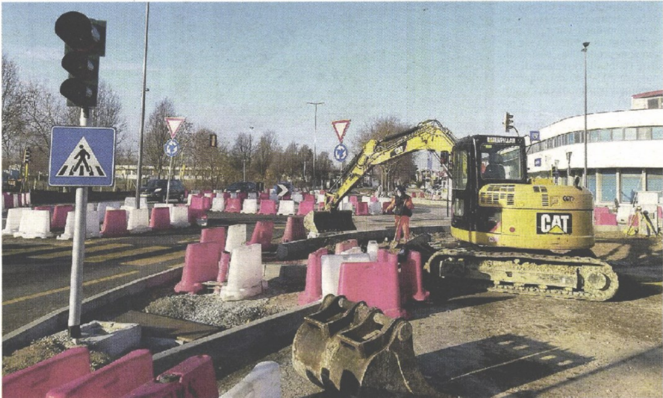
MIRANO I lavori per la realizzazione della rotonda in via Matteotti. In alto l'assessore Giuseppe Salviato
