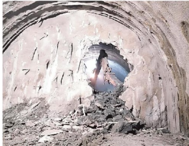
L'abbattimento dell'ultimo diaframma nella galleria
