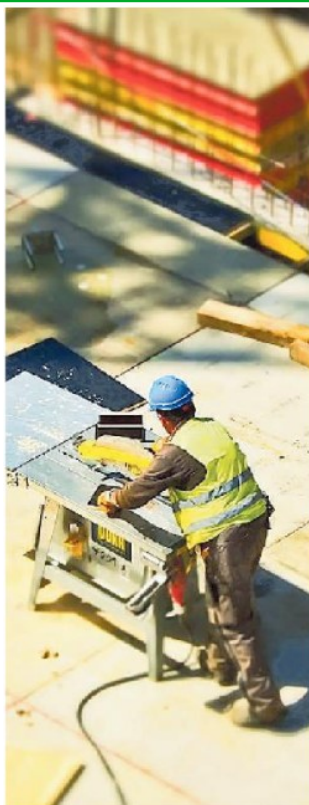
Un operaio al lavoro in un cantiere
