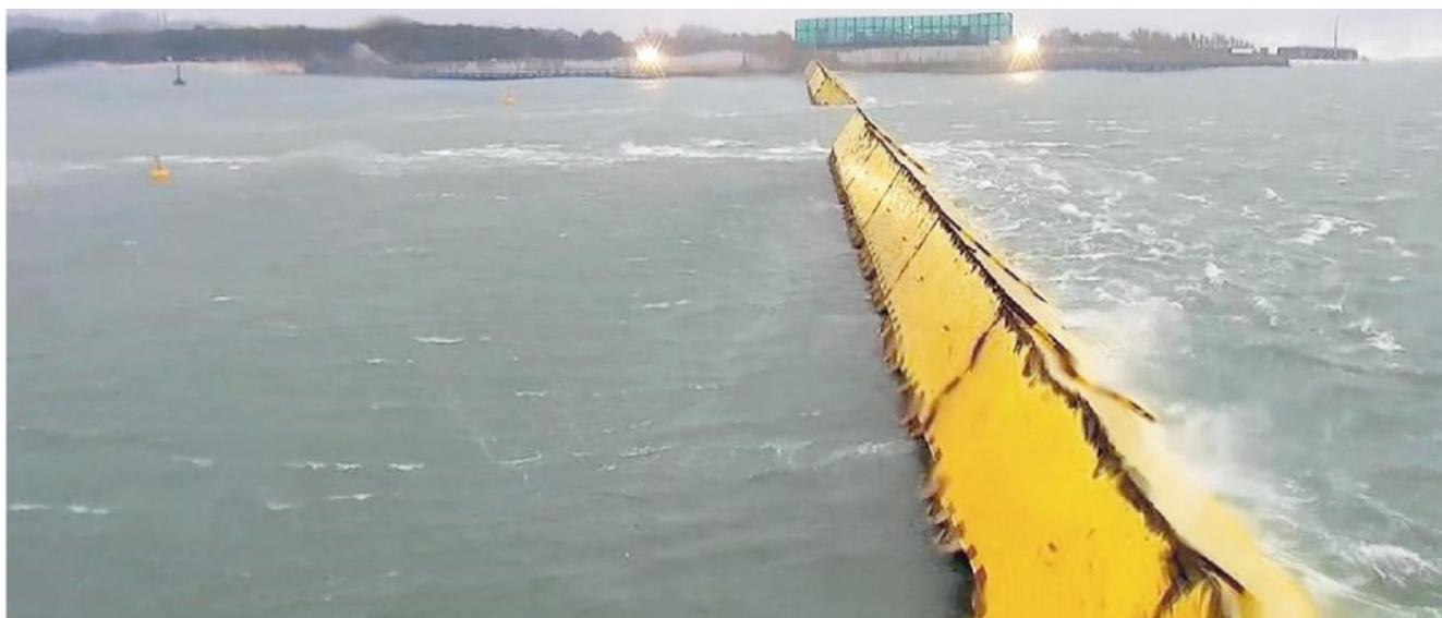
Barriera di Malamocco: le barriere del Mose sono alzate, ma alcune paratoie sono giù. Ipotesi che era stata presa in considerazione per il passaggio delle navi
