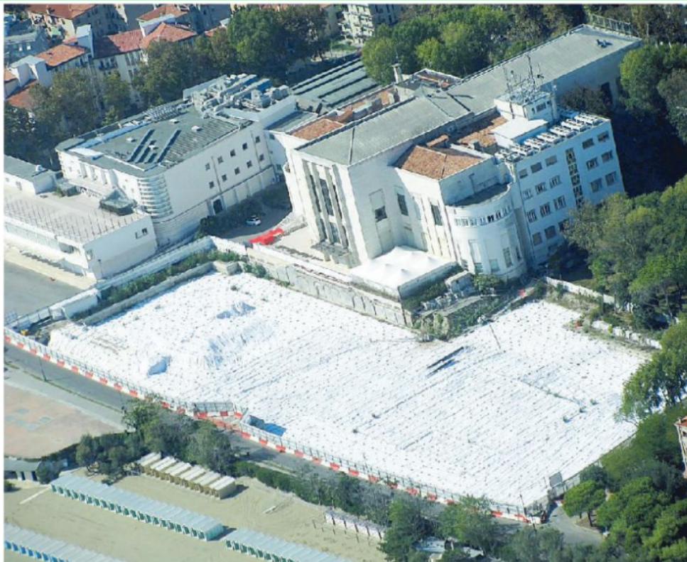
Il piazzale del Casinò del Lido ai tempi del "buco" del cantiere del Palazzo del Cinema
