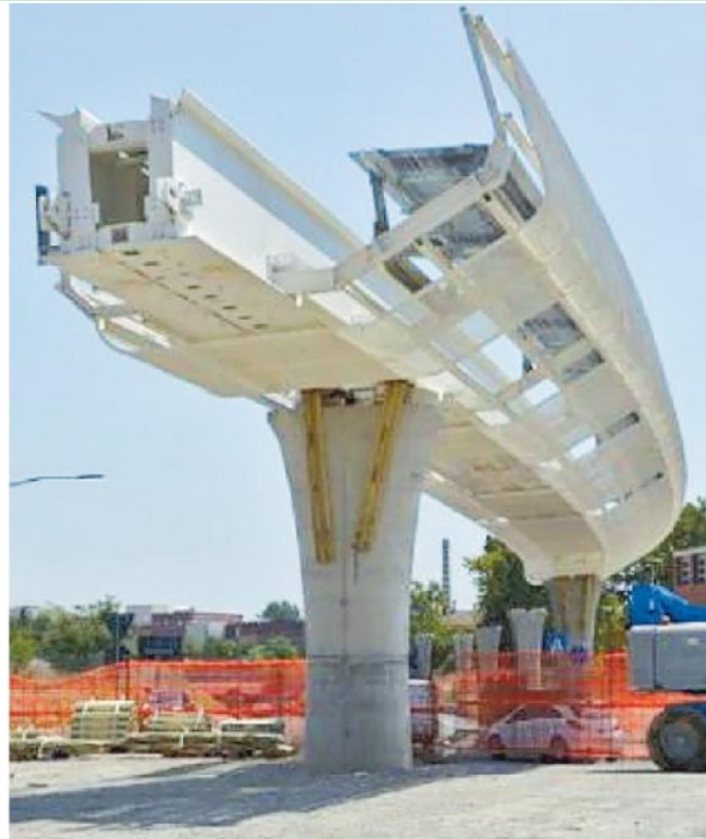
Il cantiere del collegamento monorotaia inaugurato a Bologna
