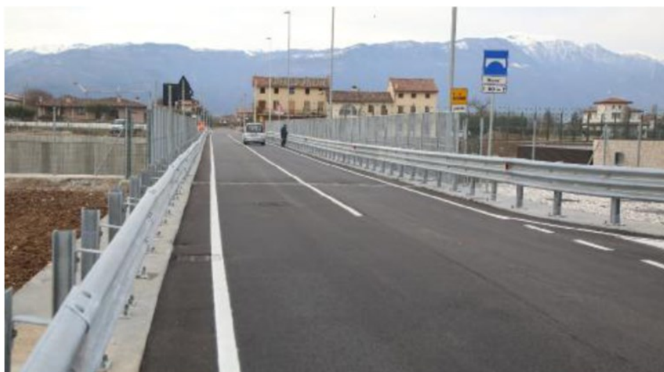
Il viadotto sulla Spv tra Rosà e San Zeno è stato l'ultimo ad essere completato. CECCON
