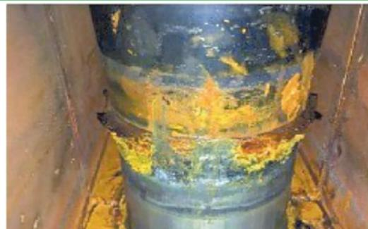
Melma e corrosione per una cerniera del Mose sott'acqua
