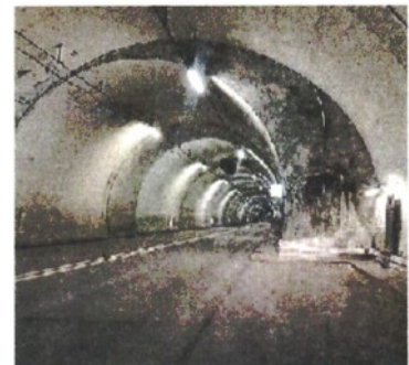
L'INTERNO della galleria del Comelico: lavori in vista
