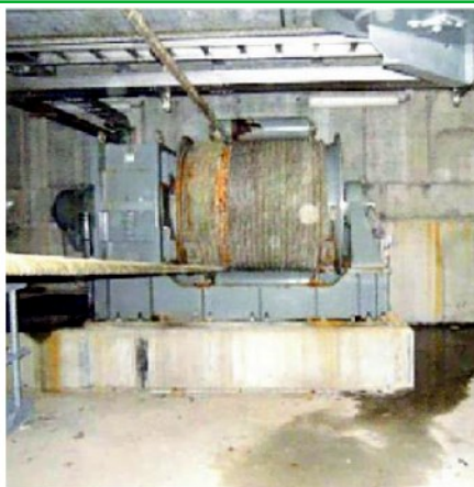
Il degrado nelle gallerie subacquee del Mose
