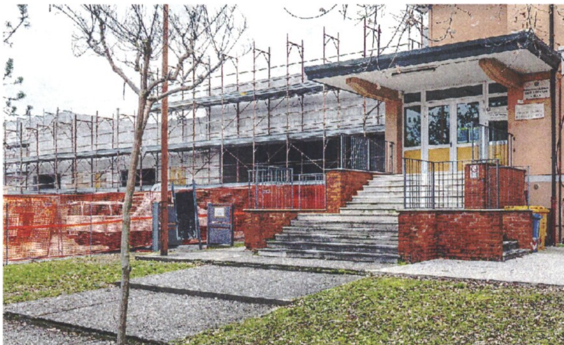
DON MILANI Il cantiere per l'ampliamento della scuola primaria fermato dopo l'altolà dell'antimafia
