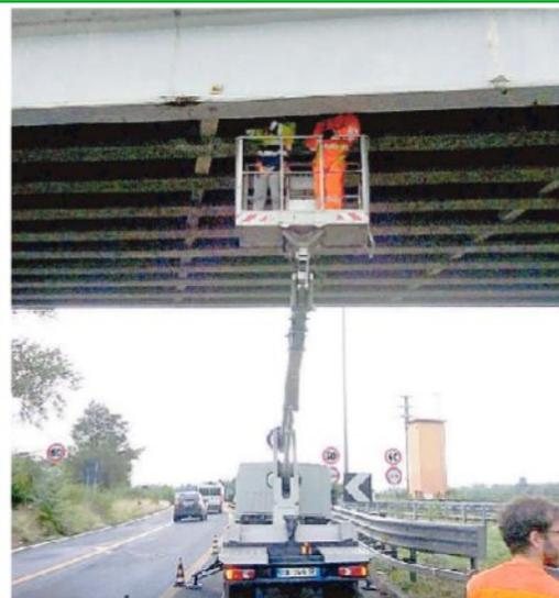
I tecnici di Autovie Venete impegnati con computer e strumenti di misurazione nelle verifiche del cavalcavia
