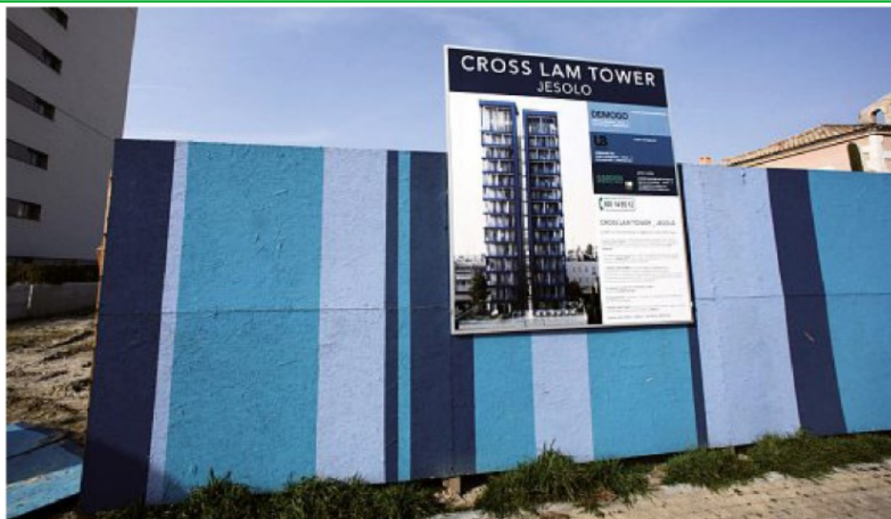
Il cantiere Una delle aree di Jesolo nella quale doveva sorgere la «torre di legno». I lavori non sono mai partiti
