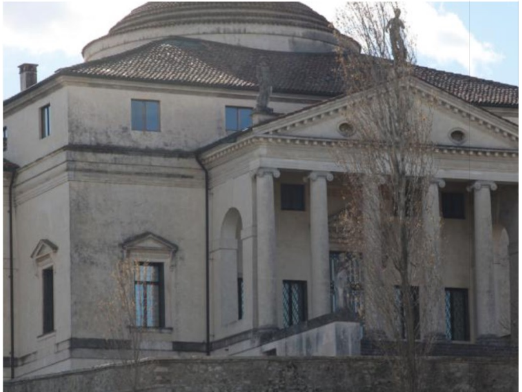
Le facciate di villa La Rotonda finiranno sotto i ferri con un lifting da 700 mila euro. COLORFOTO
