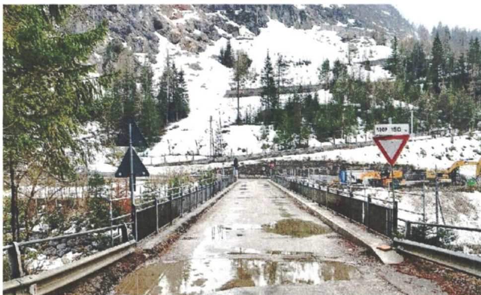
IL CANTIERE 30 giorni per sistemare il ponte della Val Visdende, nel frattempo la zona resterà isolata
