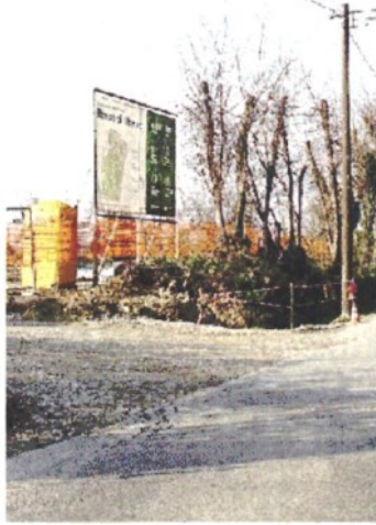
AFFARE Il cantiere della lottizzazione di via del Tinto
