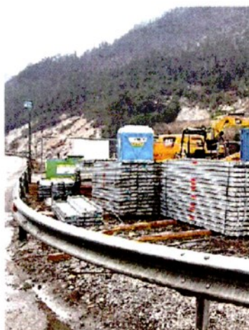
LAVORI al via da oggi in Val Visdende per sistemare il ponte
