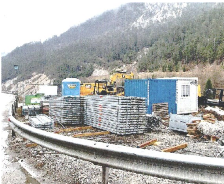
LAVORI IN CORSO ponteggi sul ponte, operai all'opera a San Pietro
