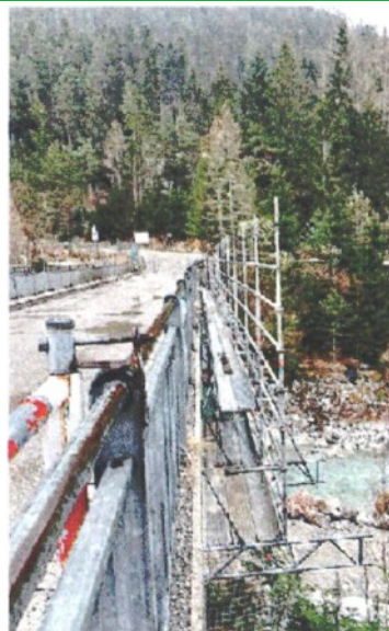
RICOSTRUZIONE del ponte post Vaia
