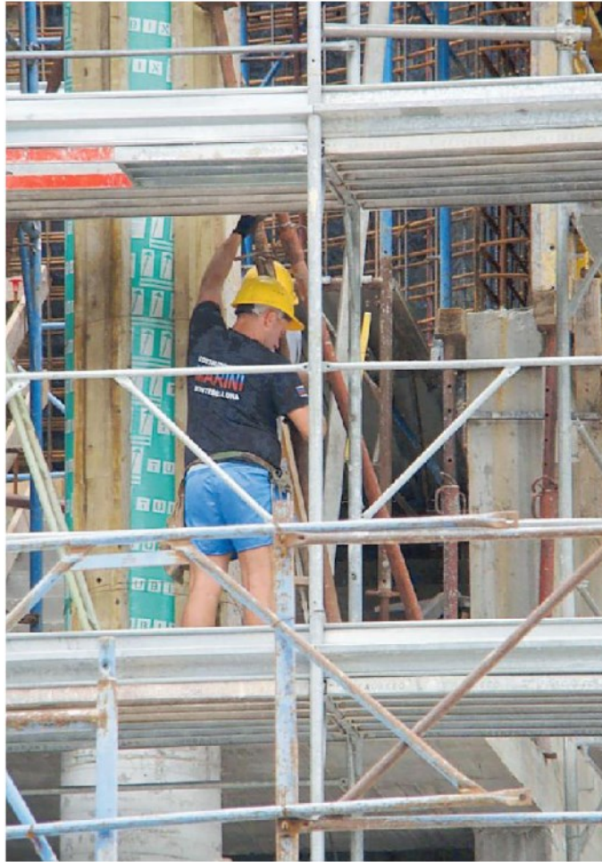
Un operaio impegnato in un cantiere per una ristrutturazione
