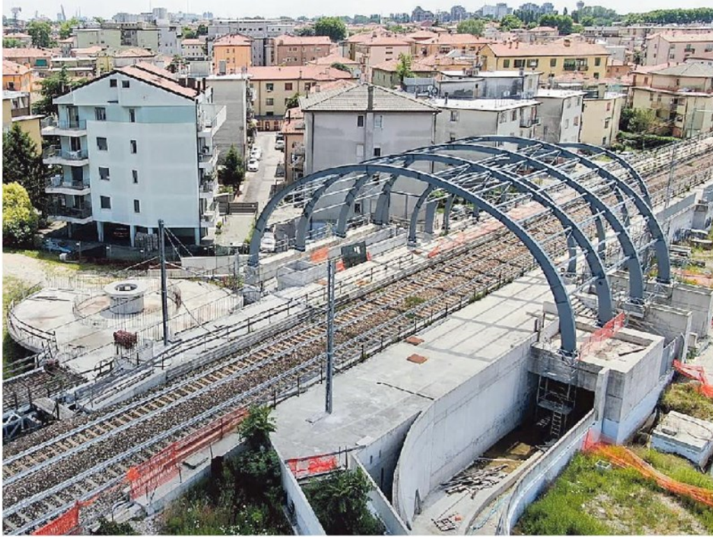
Il cantiere per la realizzazione della stazione lungo via Olimpia
