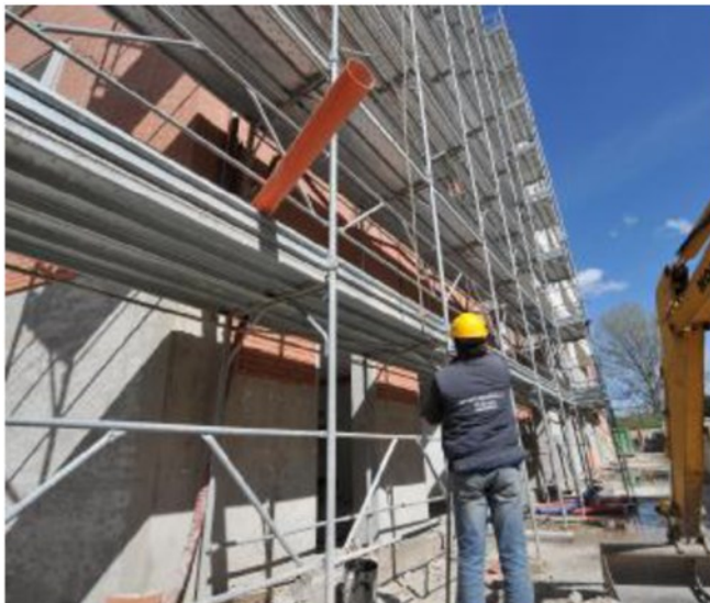
Un cantiere edile
