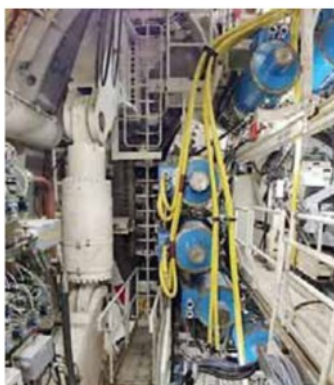
• I macchinari che scavano la roccia
