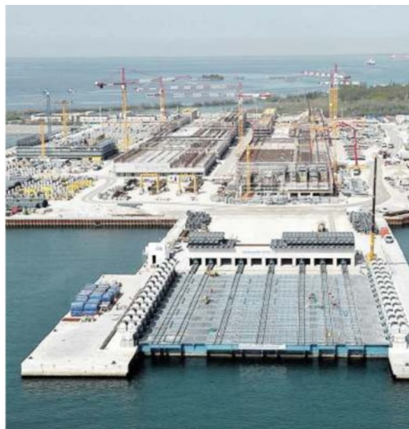
Una panoramica del Mose a Venezia
