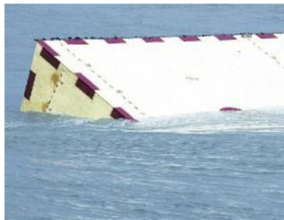
DIGA MOBILE Una delle paratoie che compongono il sistema Mose
